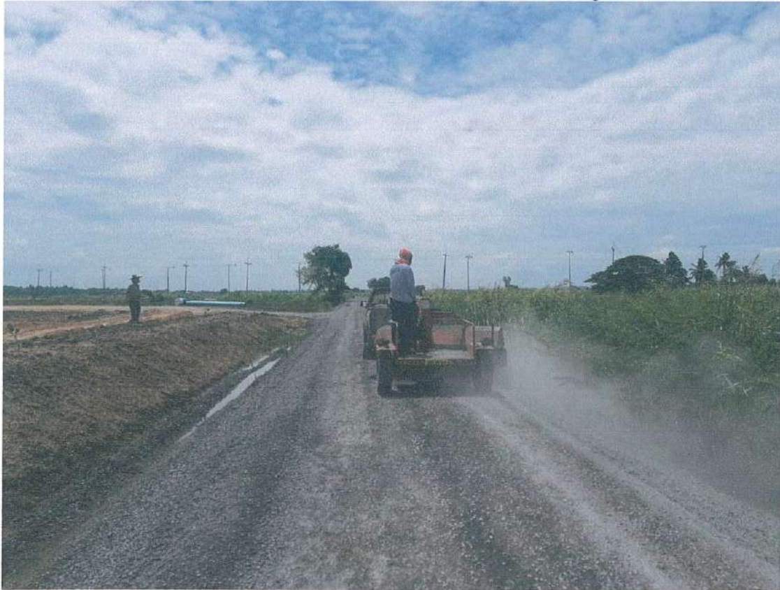
โครงการก่อสร้างถนนลาดยางแอสฟัลต์ติก คอนกรีต หมู่ที่ ๑
