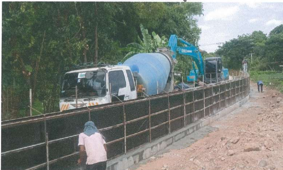
โครงการซ่อมแซมถนนแอสฟัลต์ติกคอนกรีตสายจากสะพานข้ามวัดโคกพุทรา หมู่ที่ ๑ ถึงสามแยกบ้านนายอนันต์ หมู่ที่ ๓
